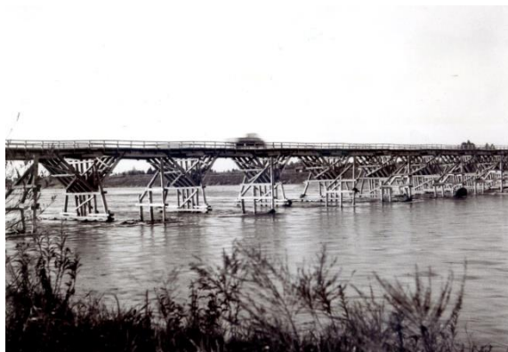
提供写真：かつて健在なりし頃の 安田橋 (昭和 31 年 7 月流失)
